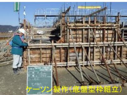
ケーソン製作(底盤型枠組立)
